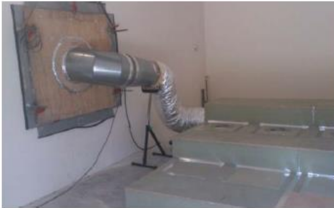
Рисунок 1 Соединение воздуховода с трибунами
